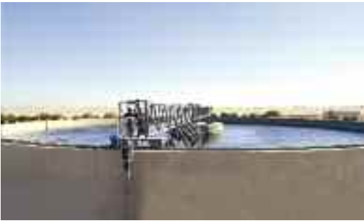
أحواض الترسيب في محطة الصليبية
