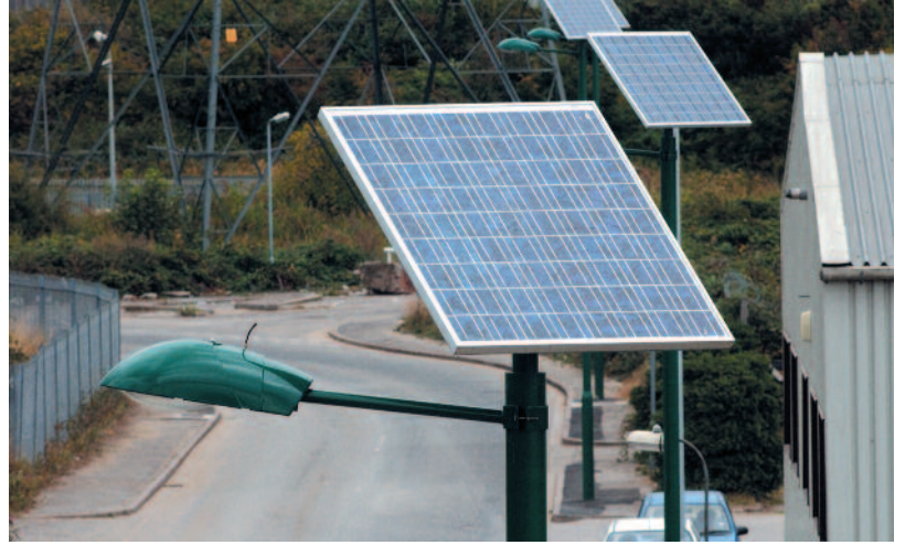
لوحات فوتوفولطية لإنارة مصابيح الشوارع بالطاقة الشمسية
