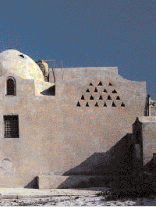
فتحات هرمية الشكل توجه النسائم عبر المبنى
