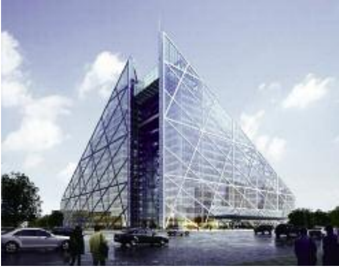
فوق: مبنى "باركفيو غرين" الى اليمين: مبنى "لينكد هايبريد"
