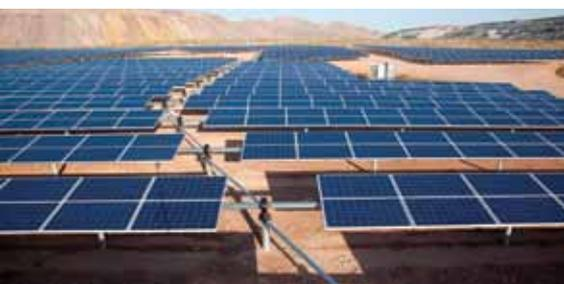
بدأ التشغيل التجاري لمحطة الكهرباء الشمسية في محافظة ظفار في عُمان، التي تقدر قدرتها المركبة بنحو 1667 كيلوواط. وهو المشروع التجاري الأول من نوعه الذي يربط بالشبكة الكهربائية، ويتضمن تركيب 1617 لوحاً شمسياً على مساحة 8000 متر مربع.
