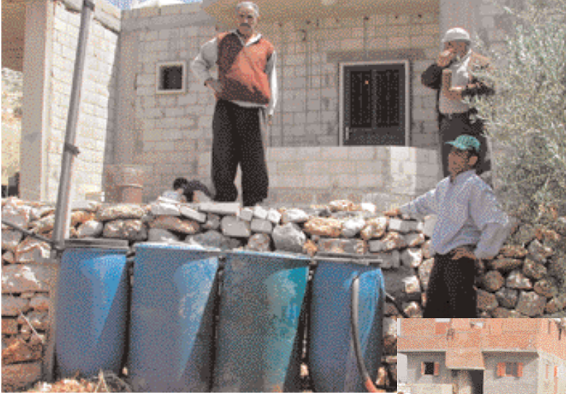
نظام لمعالجة المياه الرمادية واعادة استخدامها في الري بالتنقيط، في منطقة راشيا، لبنان، ضمن مشروع لركز الشرق الأوسط للتكنولوجيا الملائمة و IDRC
