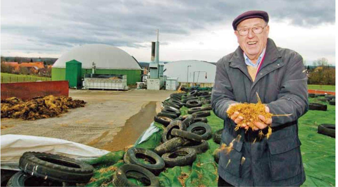
**بلدة الطاقة الحيوية:** يتم تخمير النفايات العضوية المنزلية وروث المواشي والأعشاب داخل منشأة لإنتاج الغاز الحيوي (بيوغاز) في بلدة يوندي الألمانية التي يسكنها 800 نسمة. ويستخدم البيوغاز وقوداً لمحطة محلية تولد الكهرباء والحرارة. فتغذي الكهرباء الشبكة العامة، وتوزع الحرارة في أنابيب توفر التدفئة للمنازل. ويقدر أن كل عائلة مشاركة في المشروع توفر أكثر من 800 دولار سنوياً من فاتورة الطاقة
