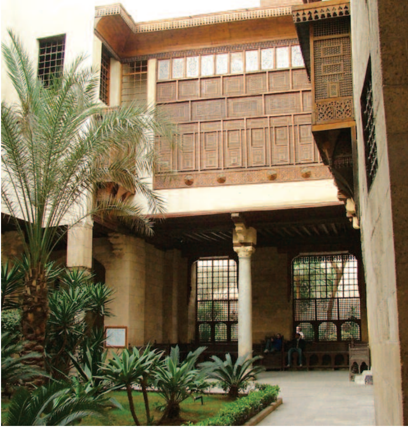
فناء بيت السحيمي في القاهرة نموذج متميز في أدائه البيئي وتعبيره المعماري
