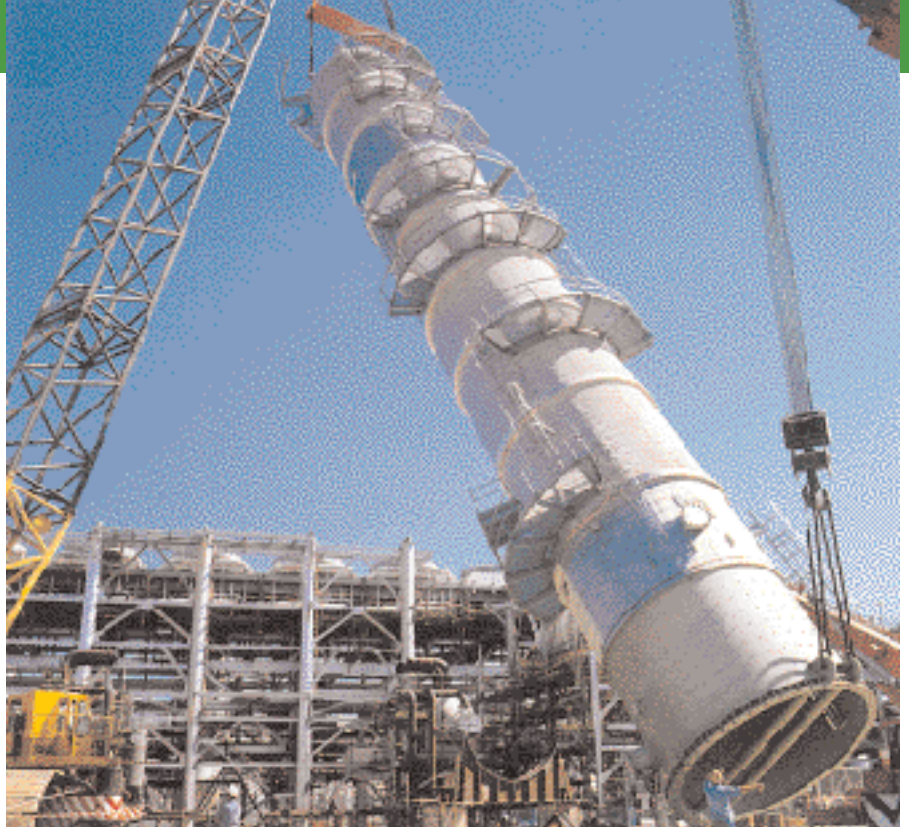
تركيب برج معالجة البروبان في منشآت الجعيمة للغاز
