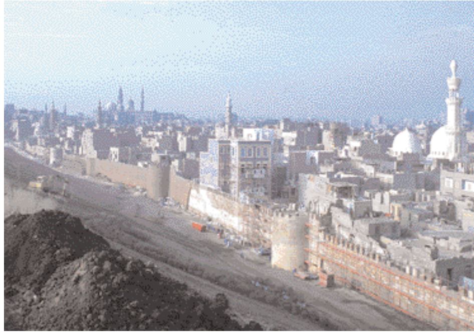
الجدار الأيوبي أثناء ترميمه
