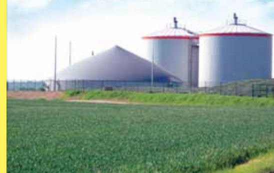
وحدة لإنتاج البيوغاز من النفايات الزراعية والحيوانية في مزرعة قرب بلدة فوكشتاين في ألمانيا. يتم هضم المواد العضوية لاهوائياً لإنتاج الغاز الحيوي الذي يستخدم لتوليد الطاقة
