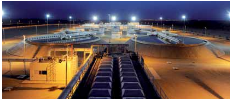
الصورة فوق: محطة الوثبة لمعالجة مياه الصرف تحت: محطة الساد
