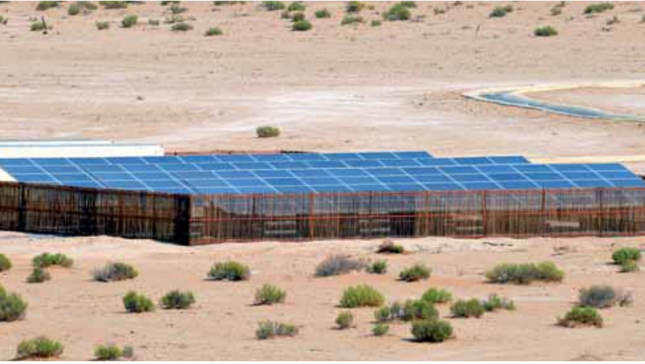
محطة تجريبية لتحلية المياه بالطاقة الشمسية في أبوظبي
