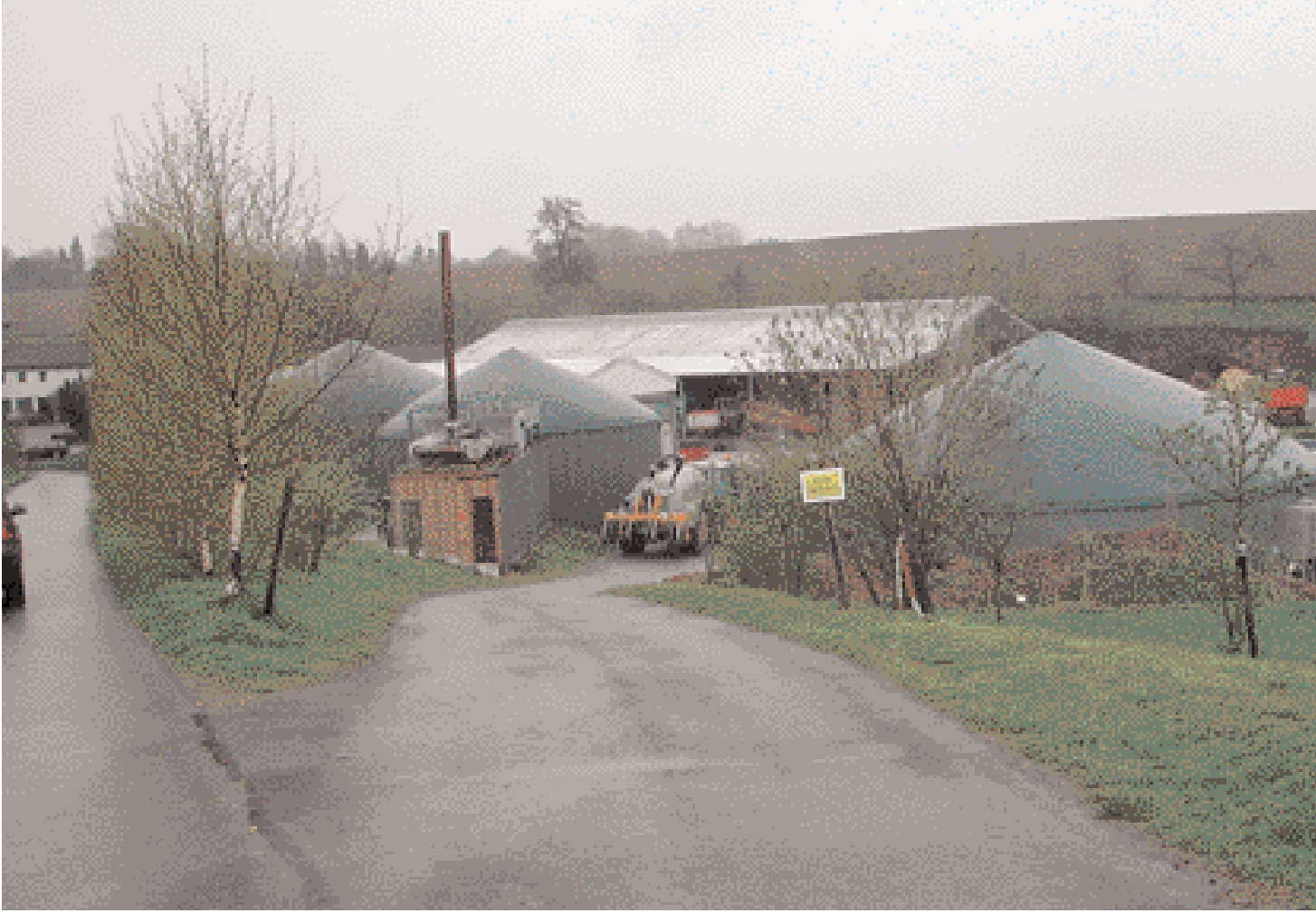
محطة لانتاج البيوغاز في فولفراث قرب دوسلدورف
