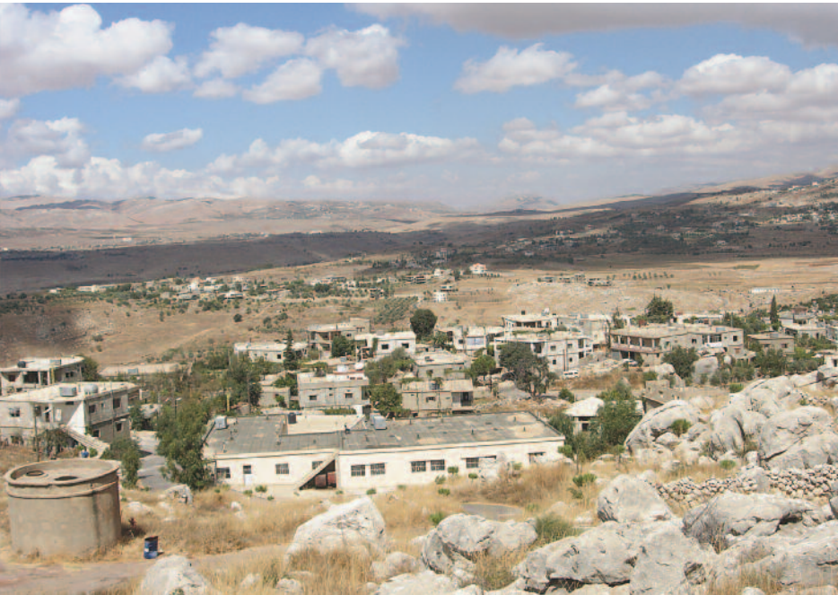
منظر عام لبلدة تنورة ويظهر في أقصى اليسار خزان عمومي للمياه لم يستعمل منذ 40 عاماً
