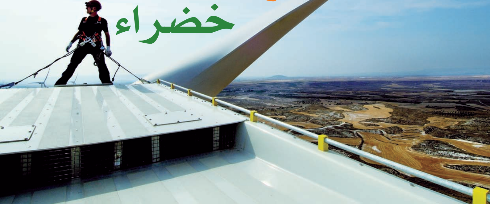
تركيب شفرة رياح (Vestas)
