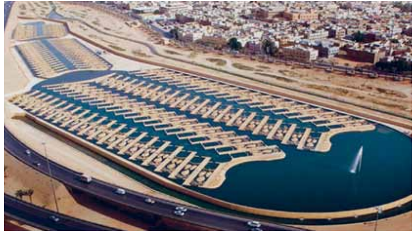
محطة لمعالجة مياه الصرف
