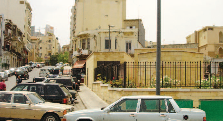
محطة تجميع الصرف الصحي (المبنى الأصفر داخل السياج) في شارع الجمارك
