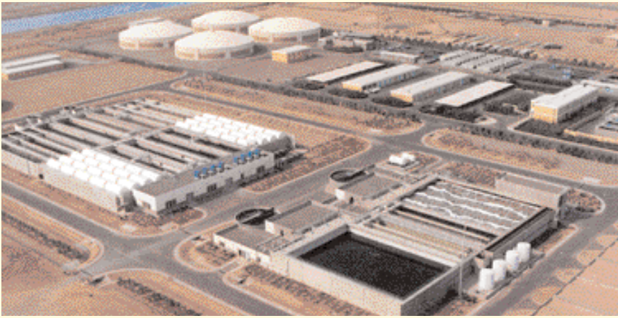
محطة لمعالجة مياه الصرف في ينبع
