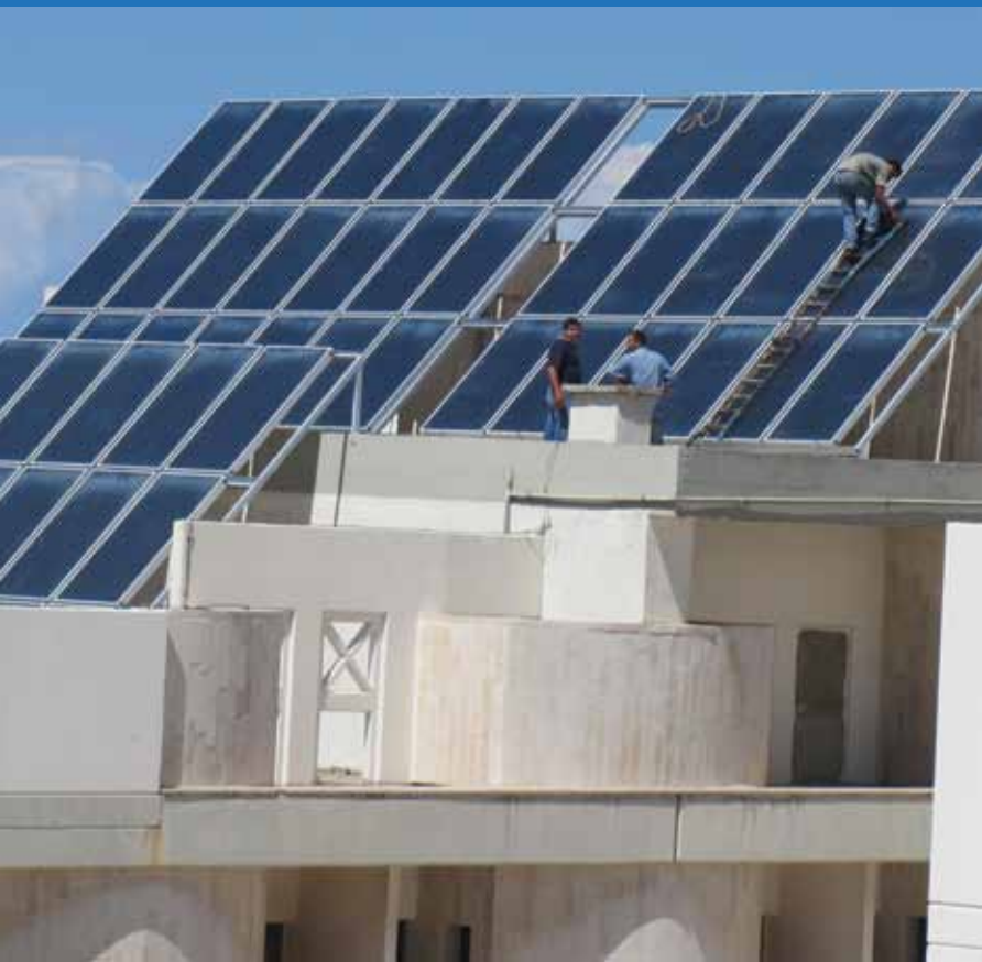
تركيب سخانات شمسية للمياه على سطح مستشفى كسروان الحكومي تسخن 6000 لتر
