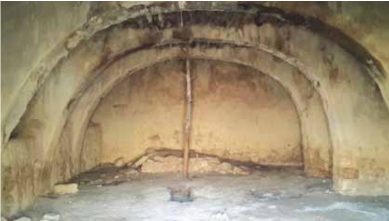
بيت تقليدي من الداخل قبل إعادة تأهيله
