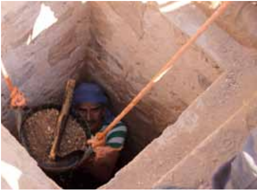
تنظيف بئر لإعادة تأهيلها
