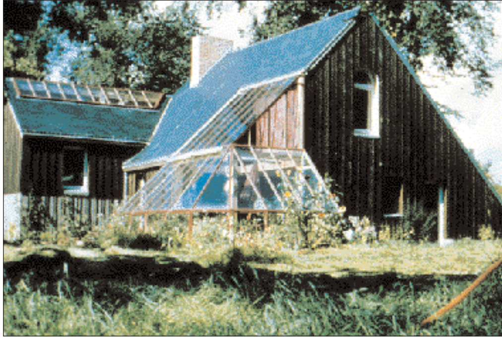
دفيئة ملاصقة للبيت تستنبت فيها الخضار وتمد البيت بالحرارة في الشتاء
