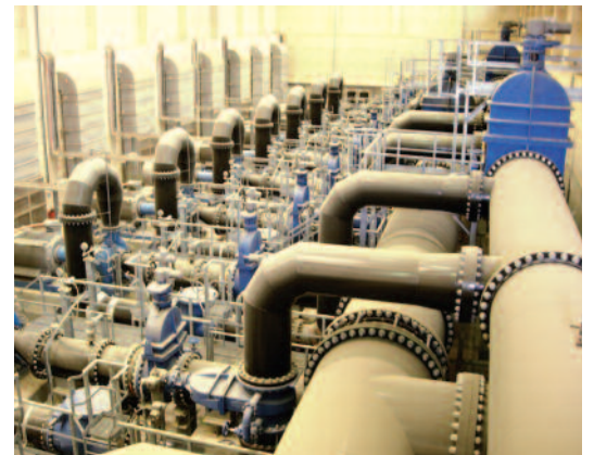
مبنى المضخات في محطة العارضية
