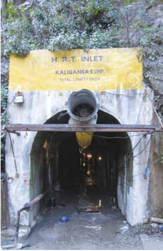
مدخل نفق طوله 2000 متر يتم إنشاؤه ضمن مشروع كالينغانغا للطاقة الكهربائية في ولاية أوتاراخند بهدف زيادة زخم مجرى النهر
