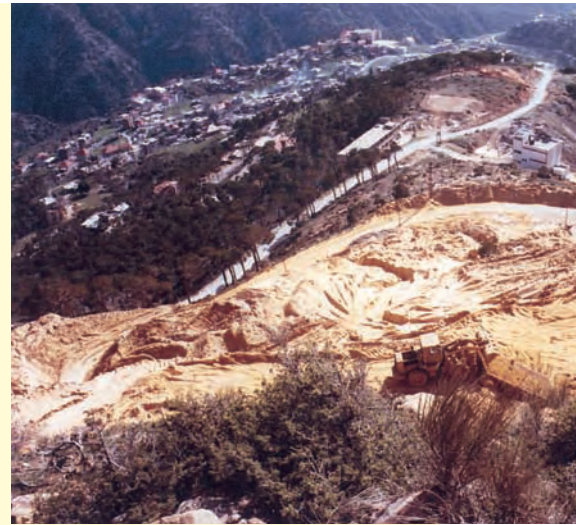
اعمال الحفر قبل وقف المحفار
