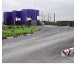
مركز لتجميع النفايات وفرزها في محافظة بنزرت
